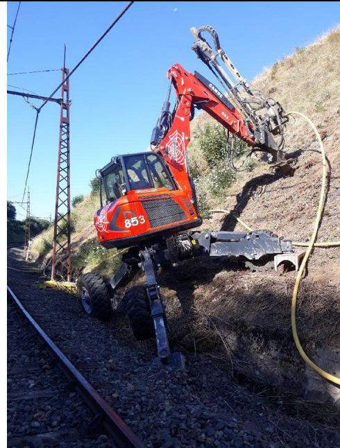
ESCAVATORE TIPO RAGNO CON PERFORATORE IN TESTA
