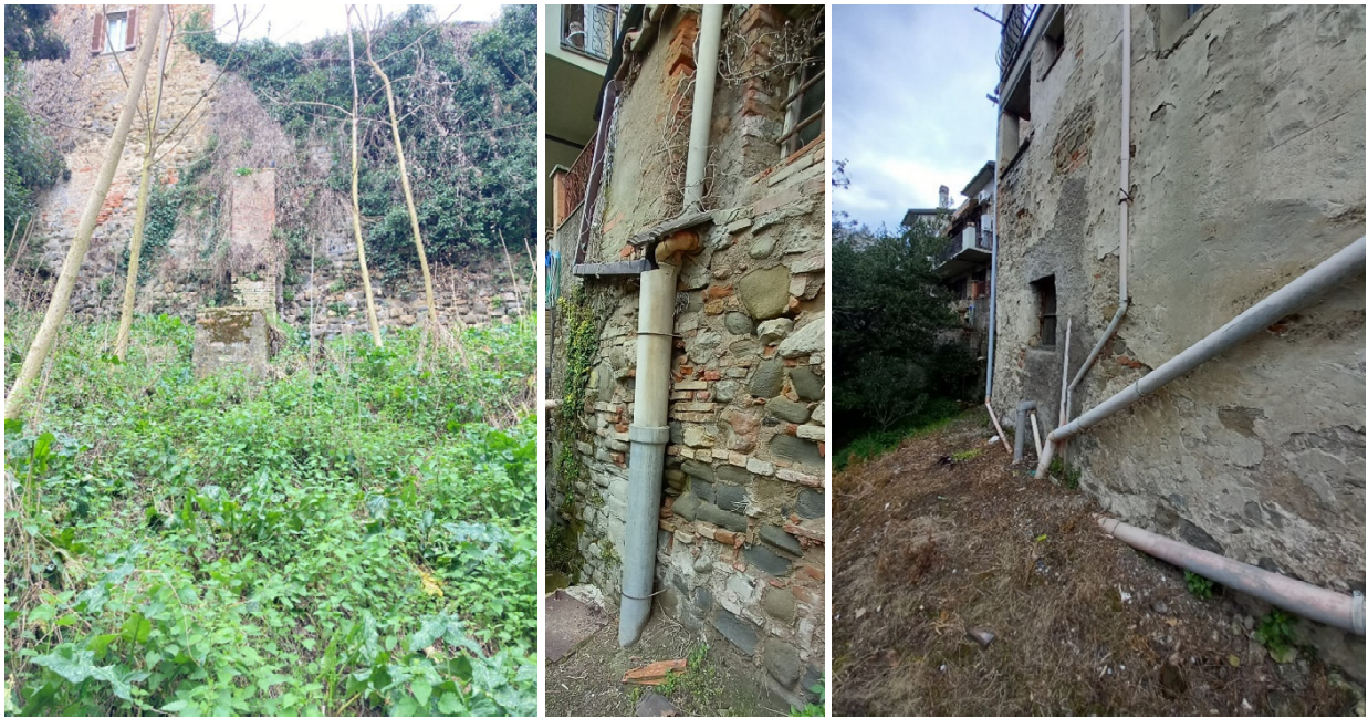
Figura 3 – Versante Ovest– stato attuale dei discendenti
