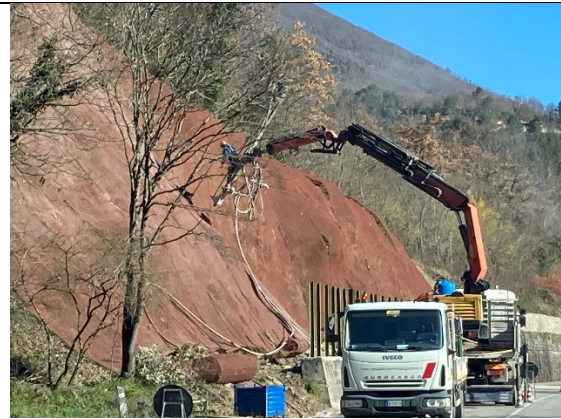
FISSAGGIO E POSA GEOGRIGLIA SU SCARPATA
