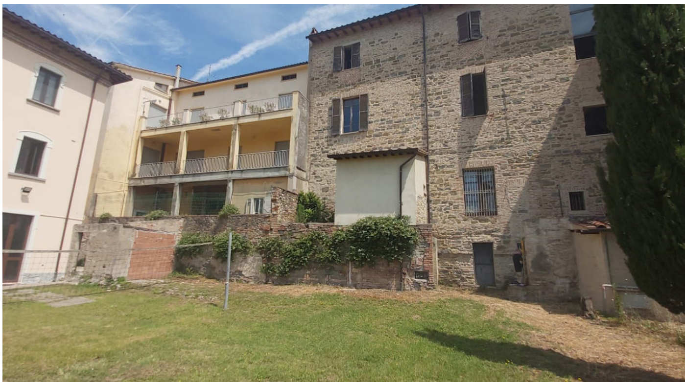
Foto 2 - prospetto sud della sede municipale del Comune di Deruta.
