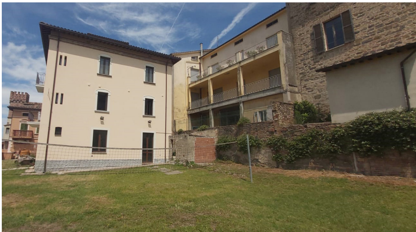
Foto 1 - prospetto sud della sede municipale del Comune di Deruta.
