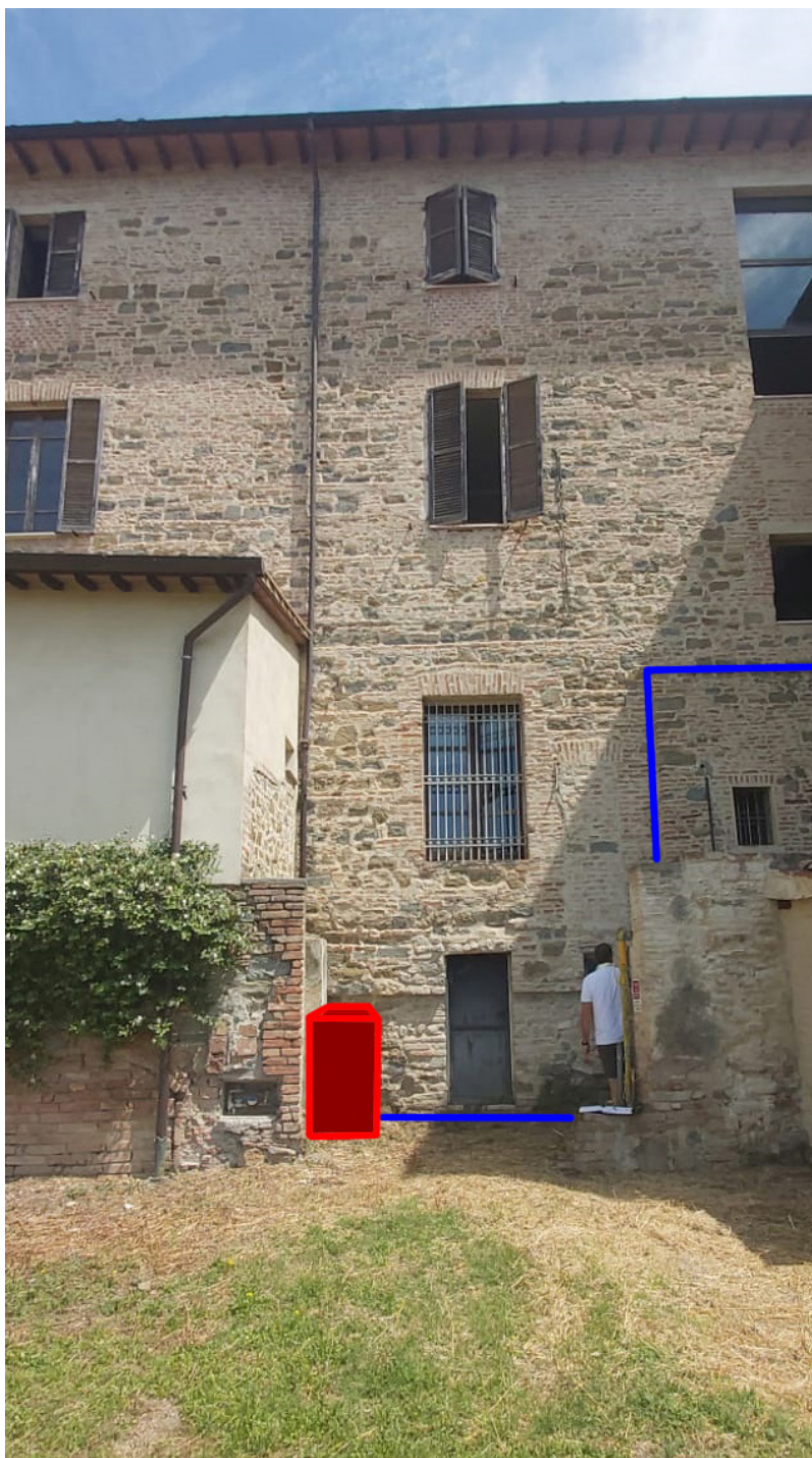
Foto 5 - prospetto sud della sede municipale del Comune di Deruta.
