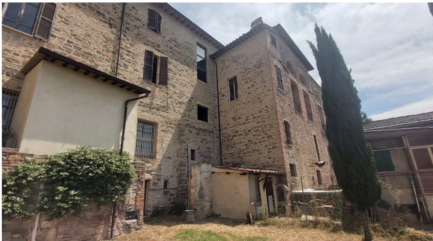
Foto 4 - prospetto sud della sede municipale del Comune di Deruta.
