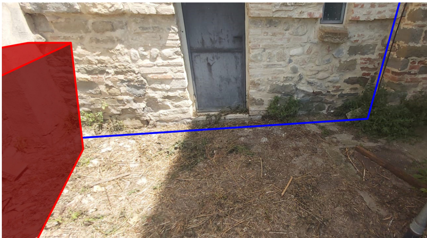
Foto 8 - prospetto sud della sede municipale del Comune di Deruta.
