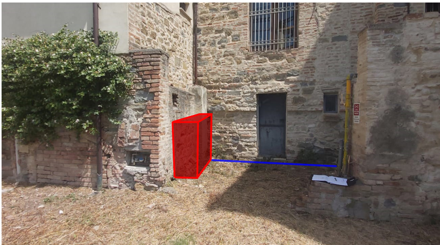
Foto 6 - prospetto sud della sede municipale del Comune di Deruta.
