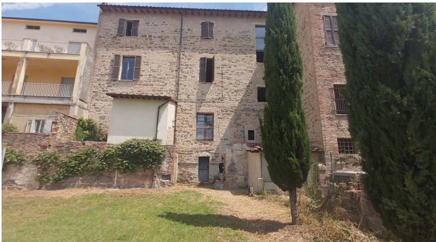
Foto 3 - prospetto sud della sede municipale del Comune di Deruta.
