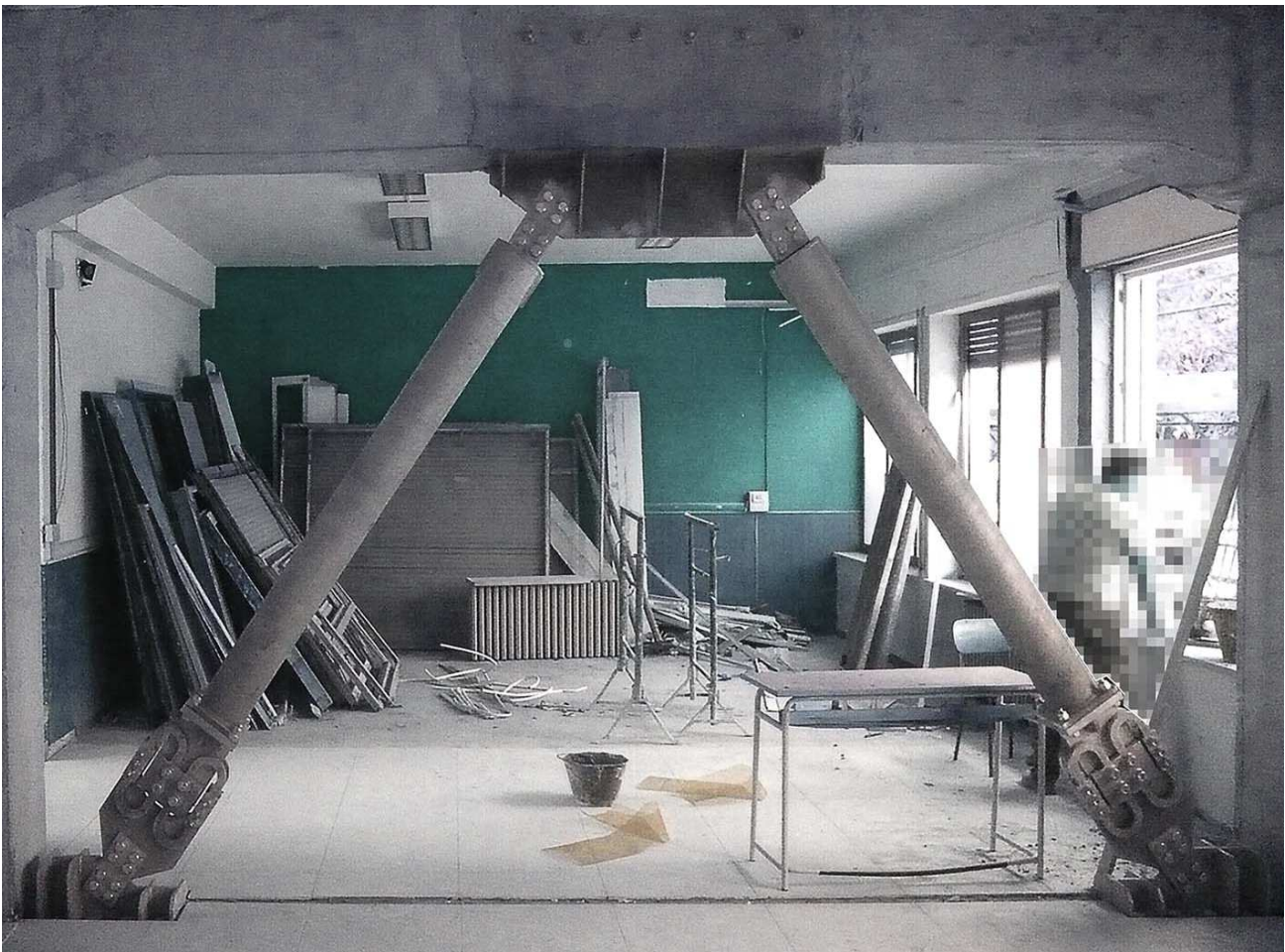
Installazione di controventi dissipativi
