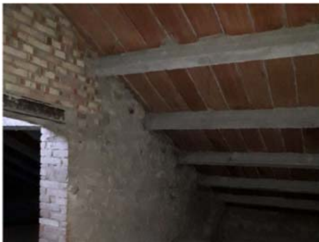
Foto 1 – copertura esistente dell'edificio in laterocemento
