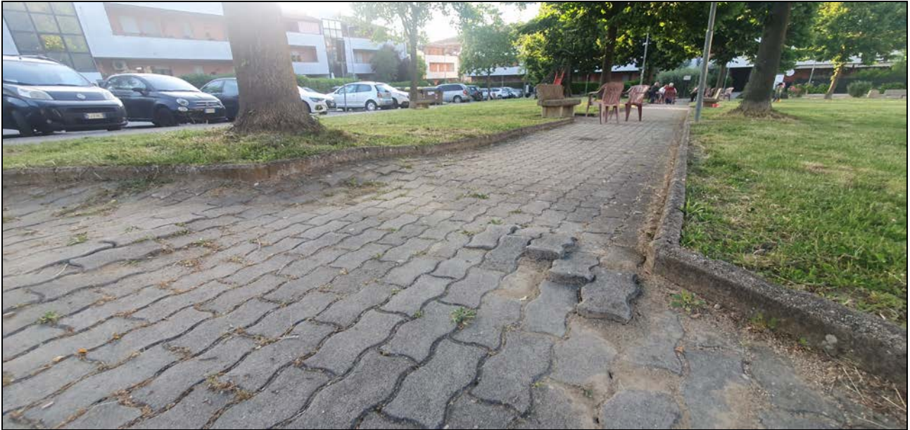
FOTO 7 (ripristino pavimentazione in autobloccanti)
