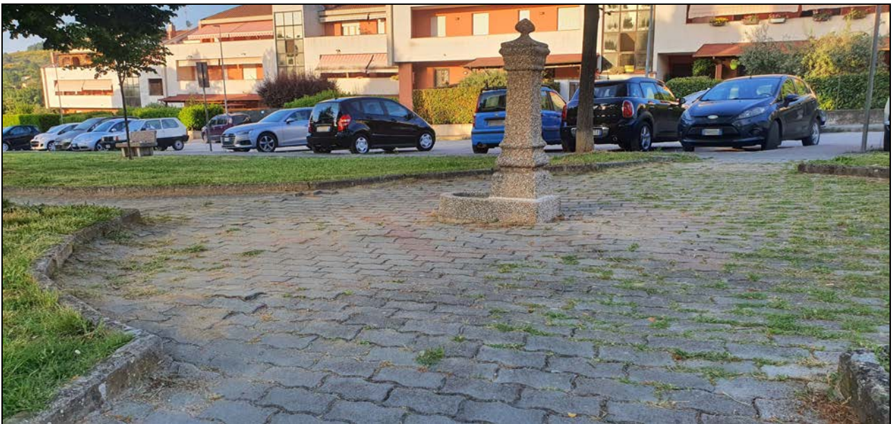
FOTO 8 (ripristino pavimentazione in autobloccanti)
