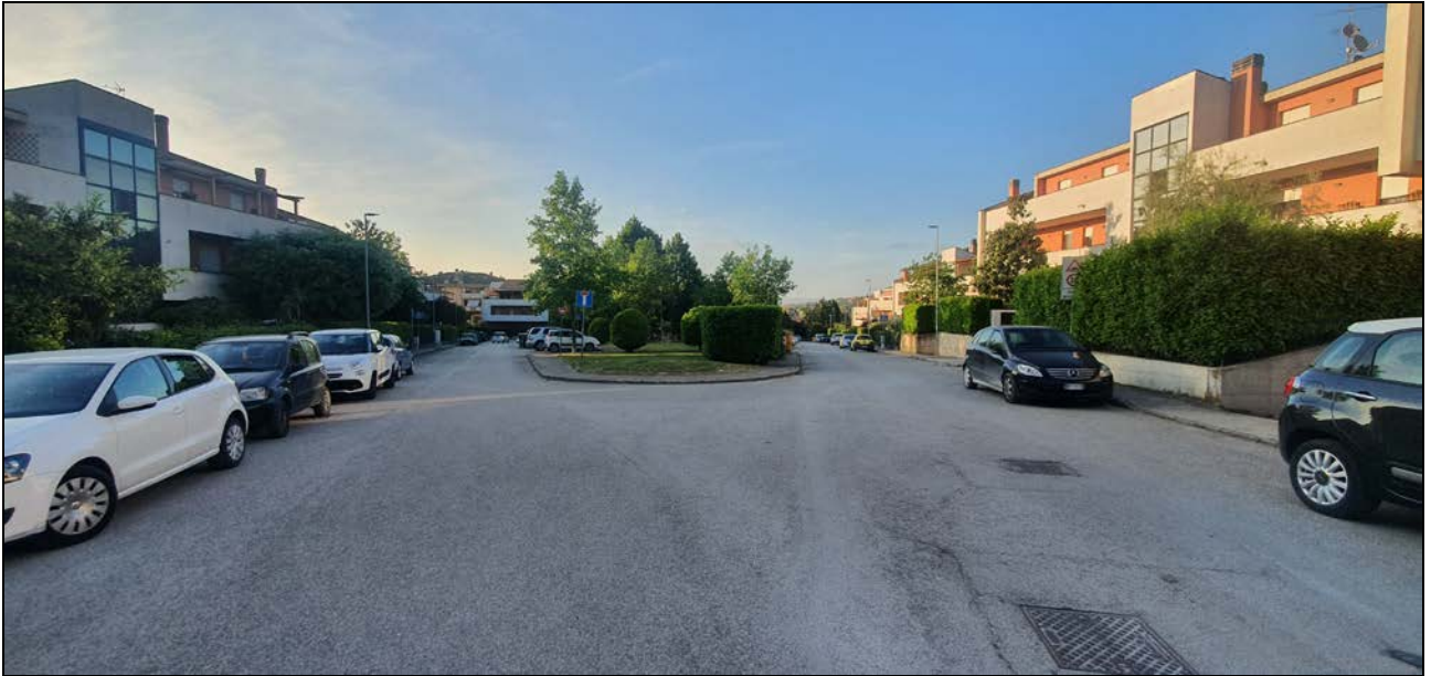
FOTO 1 (strada oggetto di nuovo tappetino bituminoso)
