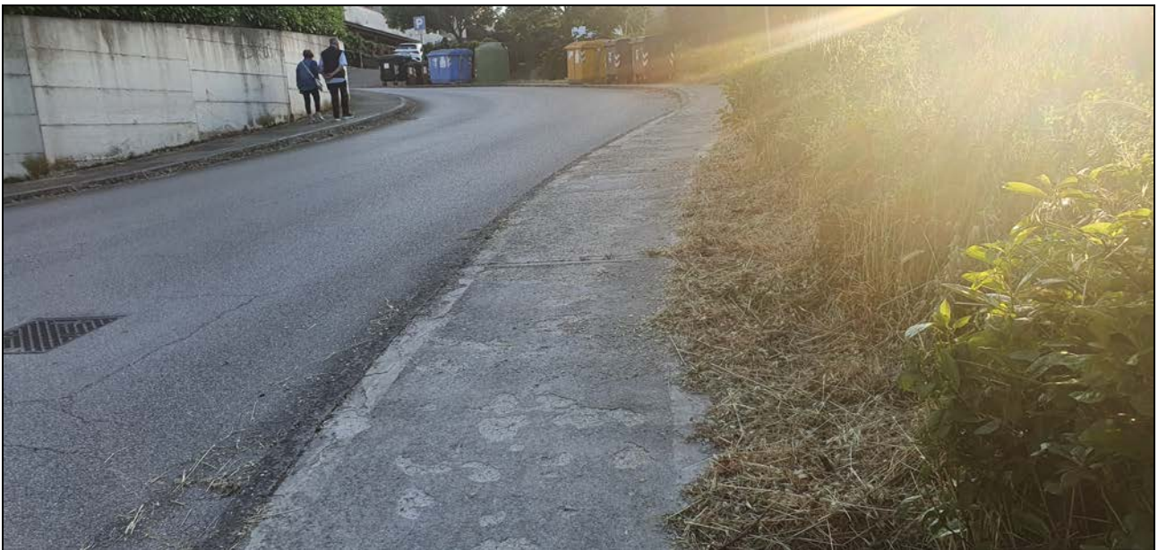
FOTO 6 (marciapiede oggetto di completamento)
