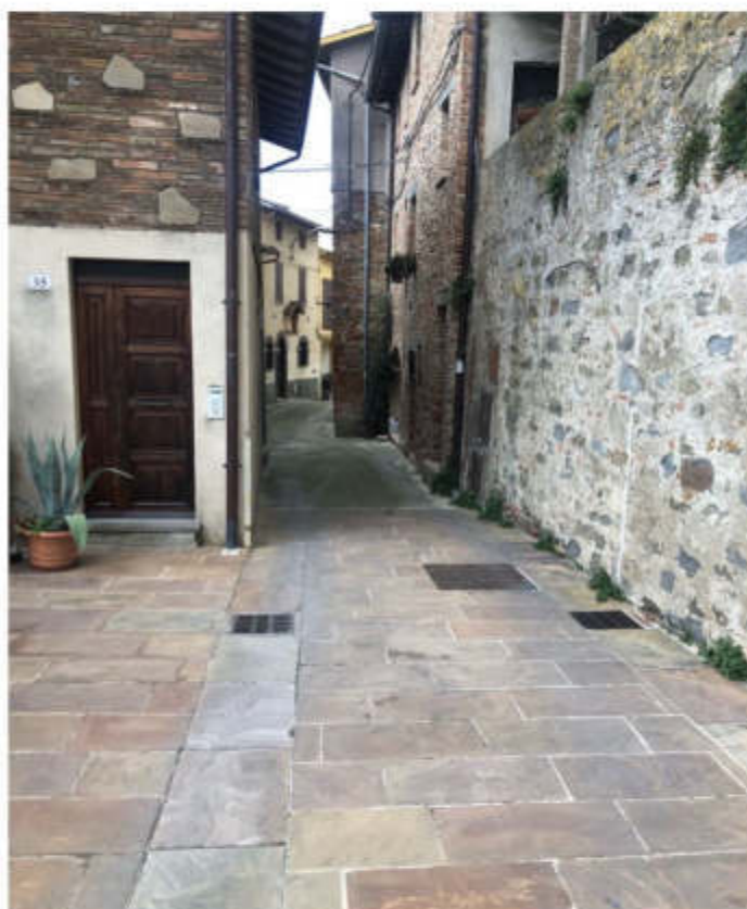
Vista Via El Frate zona interessata dalla frana e ricostruita
