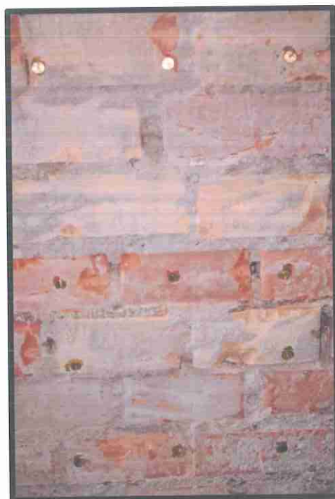
Installazione delle basi di misura
